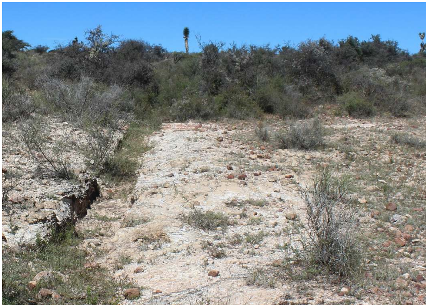
Fig. 6. Sistema constructivo tipo 3. Se observa uno de los canales y material del empedrado disgregado. Jorge Cuauhtémoc M. Huerta.
