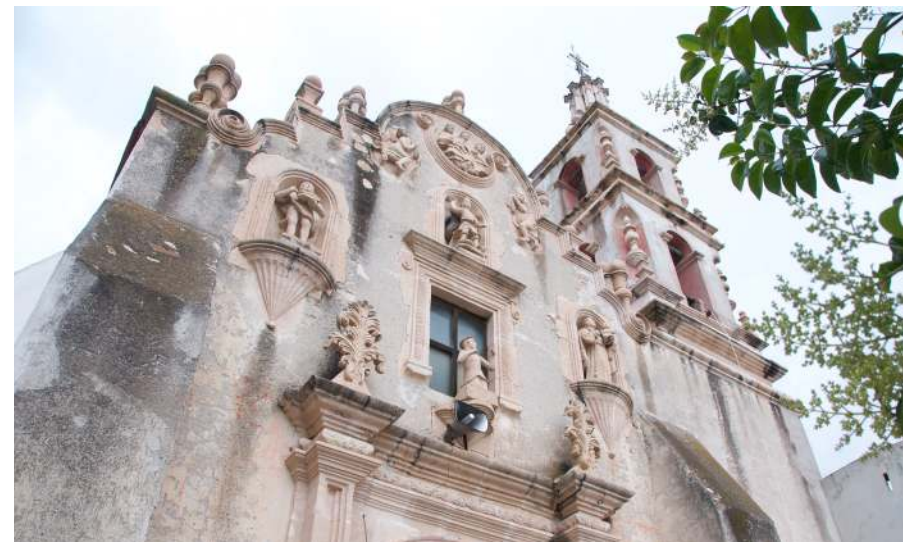
Fig. 13. Fachada. Templo y Capilla de San Nicolás Tolentino. Fuente: RWHIZ.
