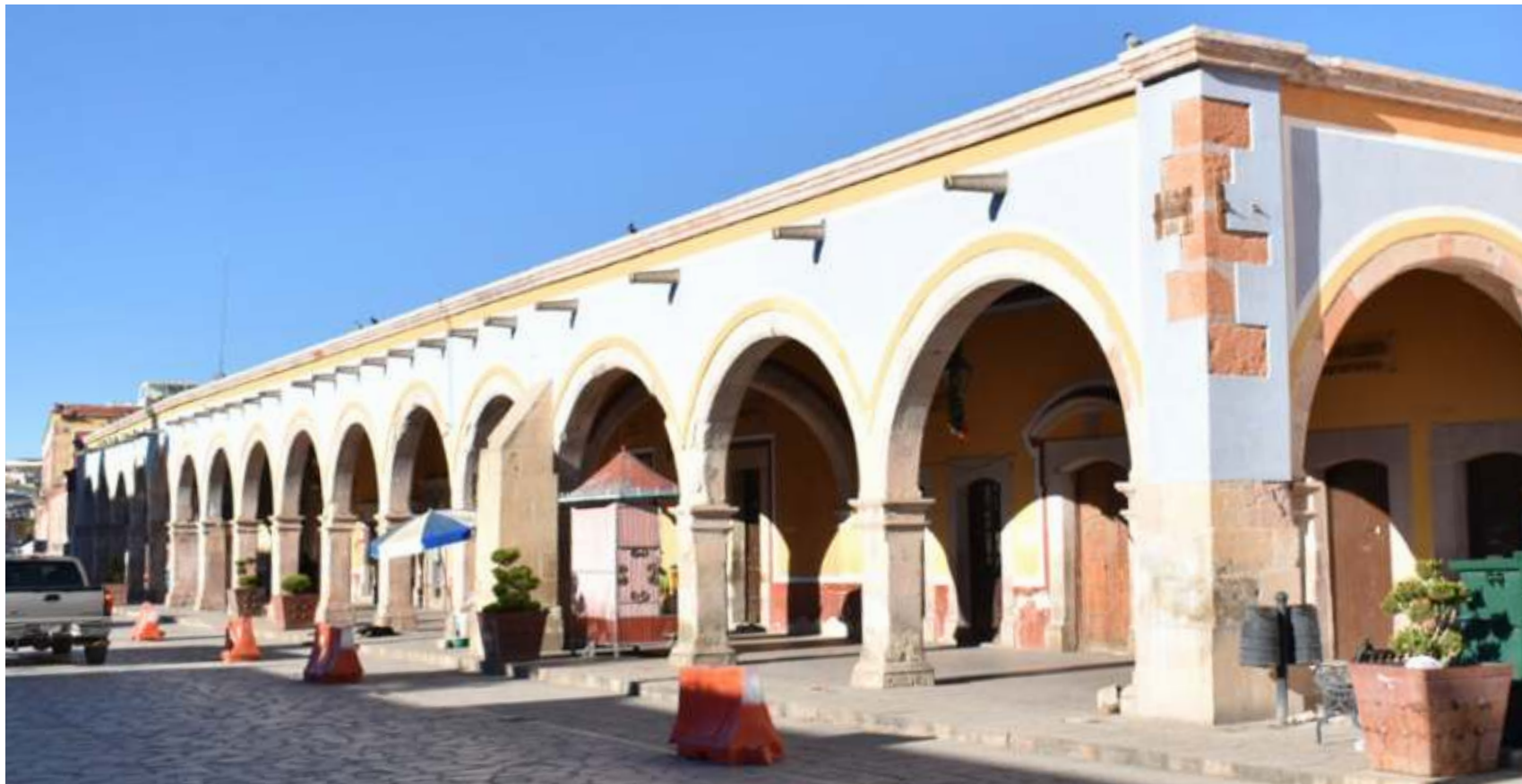
Fig. 9. Vista de una sección de los portales en la Av. Hidalgo. Fuente: Catálogo de Monumentos INAH.
