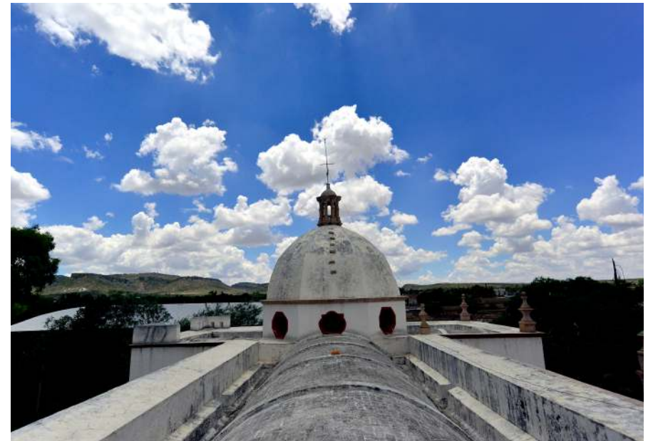
Fig. 10. Imagen de la bóveda de cañón. Fuente: Jorge Luis Sotelo Félix.
