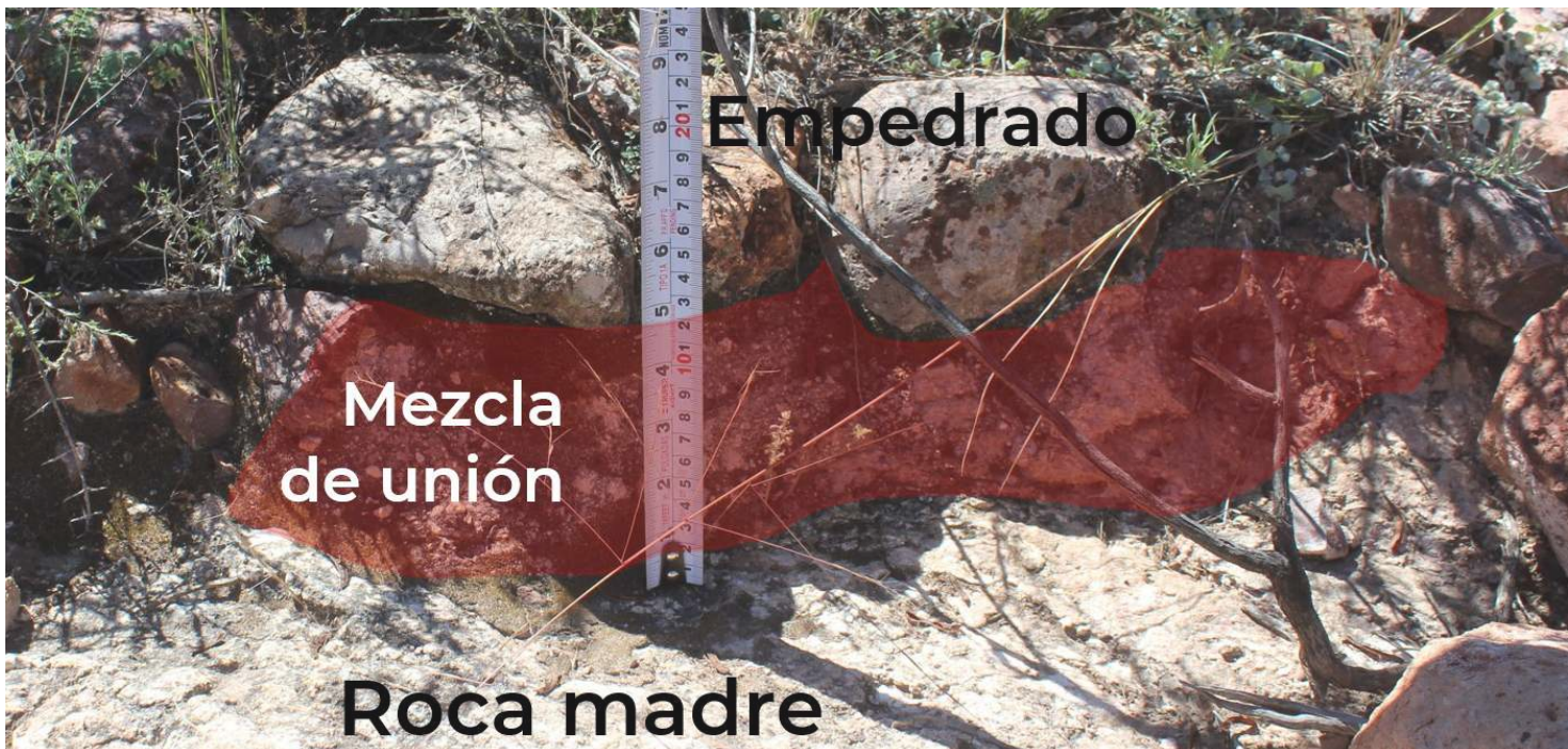
Fig. 5. Sistema constructivo tipo 3. Unión del empedrado directamente sobre la roca madre. Jorge Cuauhtémoc M. Huerta.
